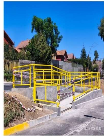
Rampa para cruce de peatones Av. El Canal.
