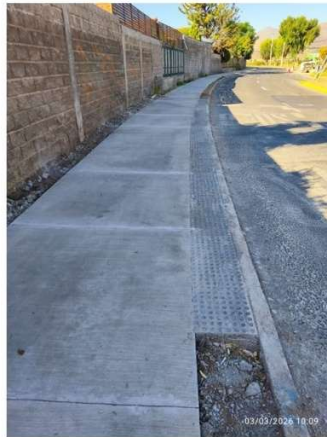
Mejoramiento bahía paradero Av. El canal Sur
