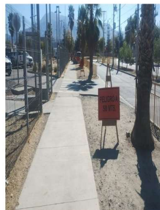
Plan de señalización Camino Apacible (trabajos en ejecución)
