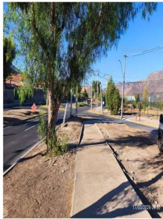
ejecución de veredas Av. El canal Norte.
