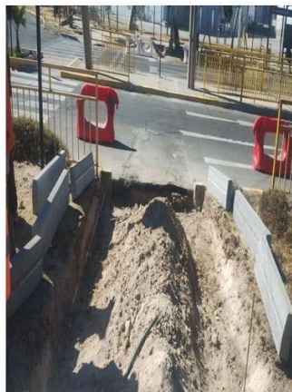
Dispositivos de rodado Camino Apacible (trabajos en ejecución)
